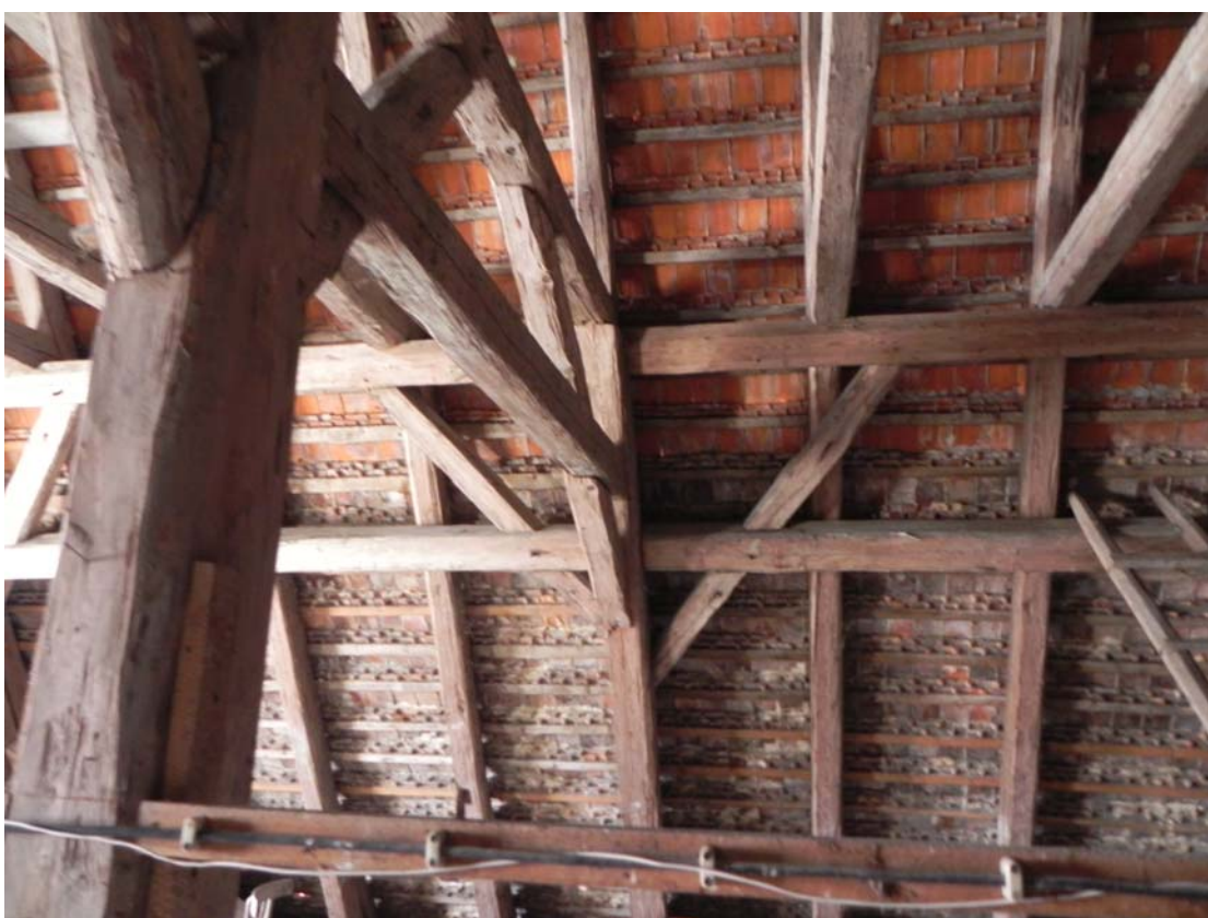
widok wewnętrznej konstrukcji dachowej
