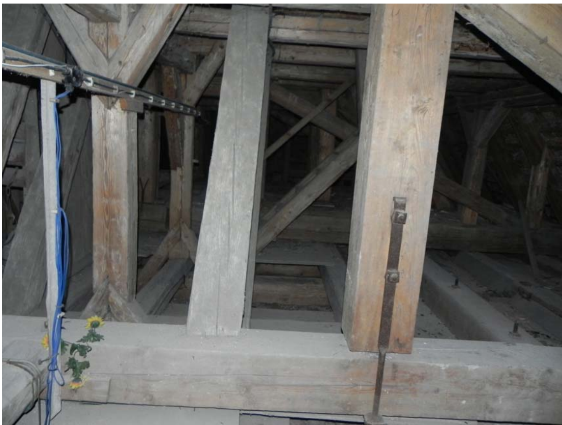
widok wewnętrznej konstrukcji dachowej
