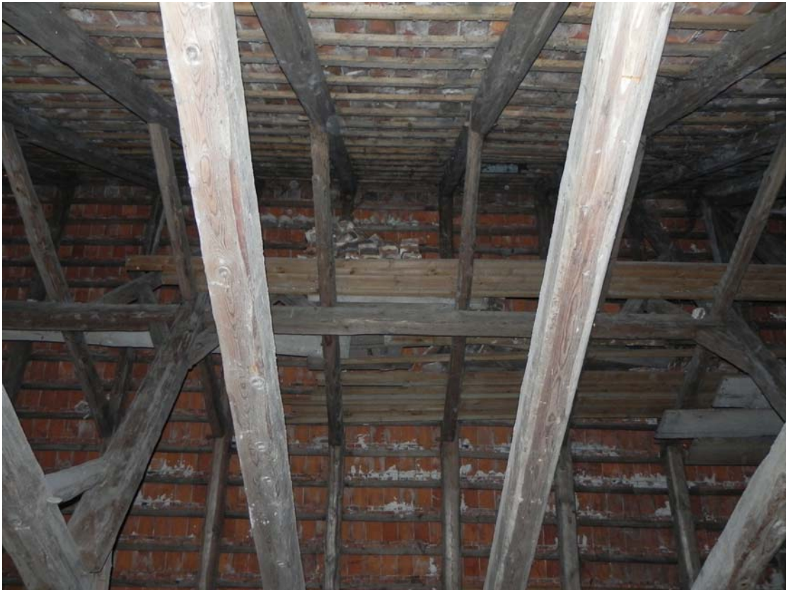
widok wewnętrznej konstrukcji dachowej
