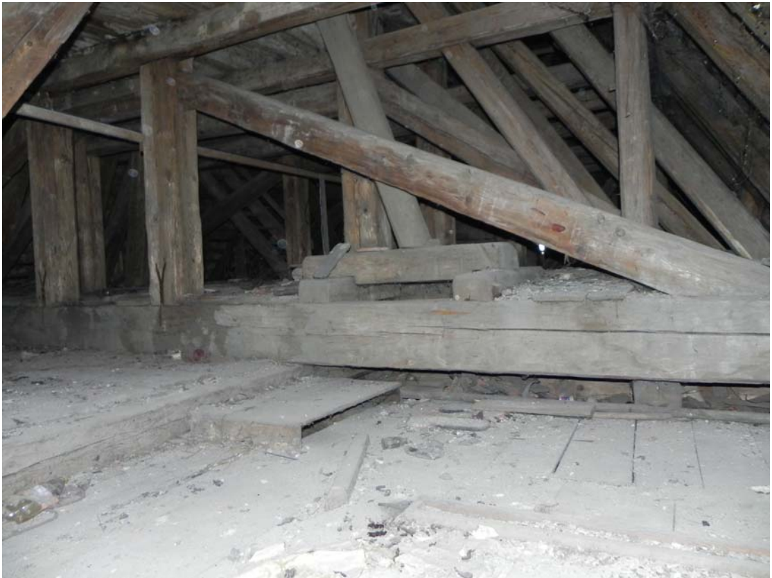
widok wewnętrznej konstrukcji dachowej
