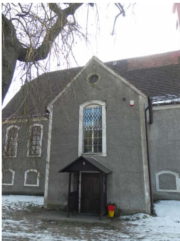
widok fragmentu elewacji tylnej
