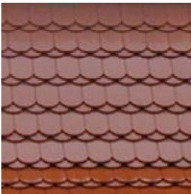
widok wykonanej połaci dachowej – krycie w koronkę
