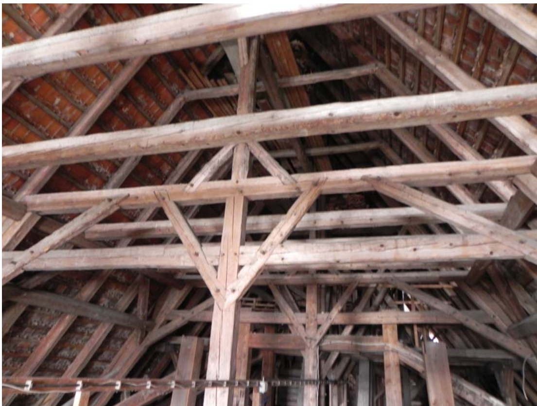
widok wewnętrznej konstrukcji dachowej
