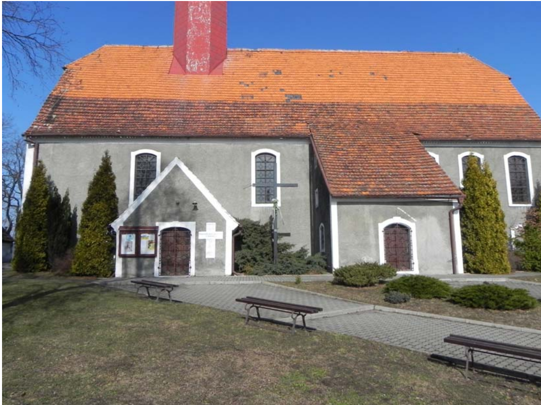
ogólny widok budynku
