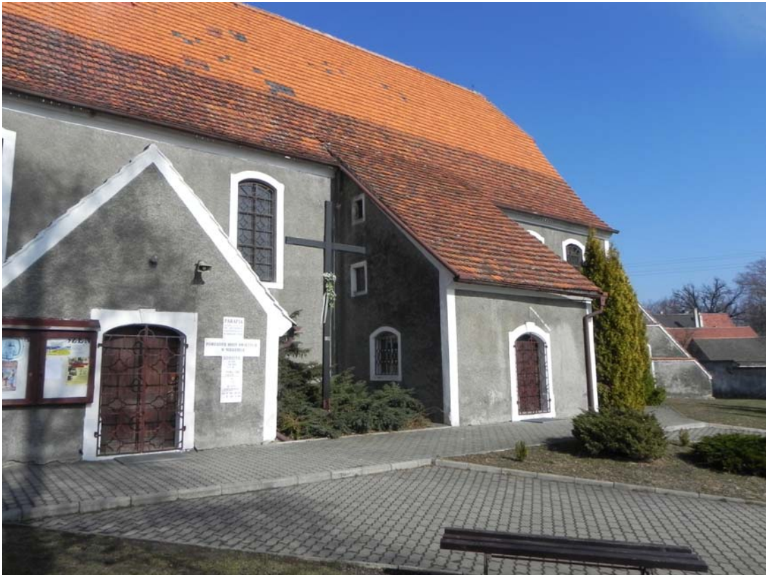
widok połaci dachu
